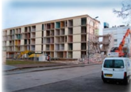
démolition 13 à 33 Robespierre
